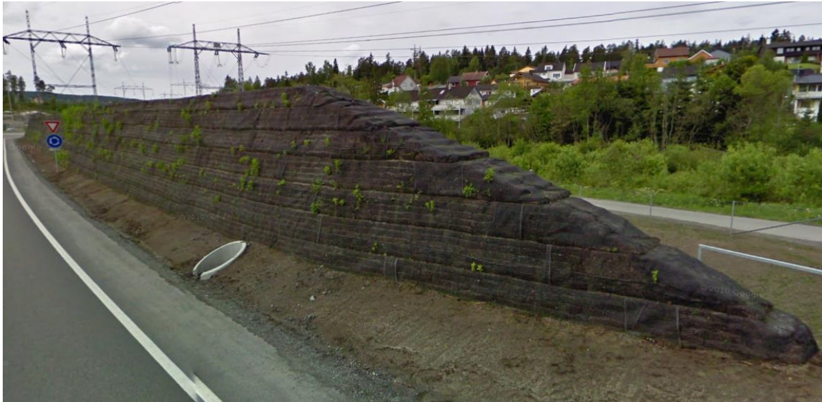
Eksempel på armert støyvoll. Bilde fra google map -Lørenskog, 4m høy 500m lang.
